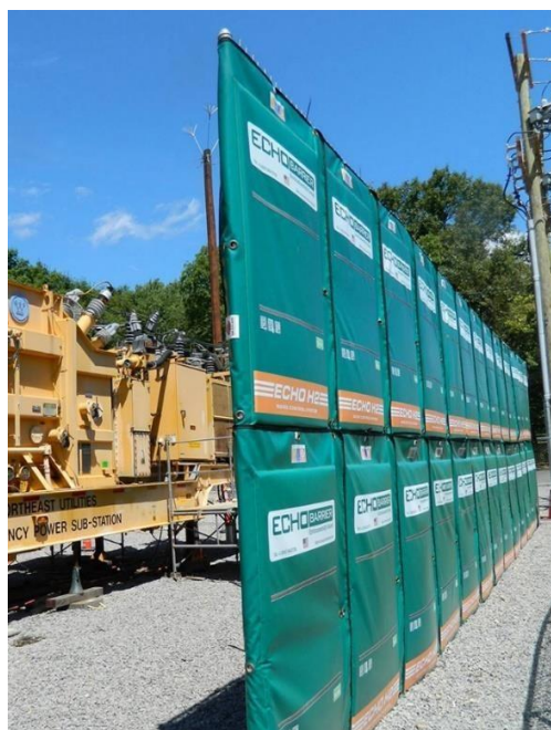
Slika 12 – Primjer privremene zvučne barijere
