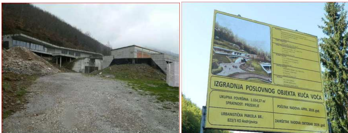
Slika 6-9: Online slika i tabla o izgradnji koja označava početak i završetak izgradnje Kuće voća (početak 2018. kraj 2019.) online izvor
