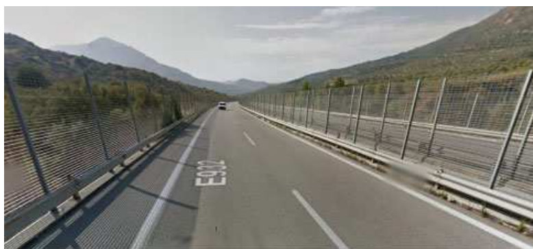
Slika 26. Primjer mreže koja sprečava sudare leteće faune sa vozilima [Debljina žice: 5 mm, dijametar okca: 40 mm, Materijal: čelik (kvadrat ili šestougao) + antikorozivna zaštita (cink/aluminijum)]
