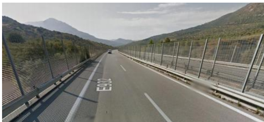
Slika 6. Primjer mreže koja sprječava sudar s letećom faunom [Širina žice: 5 mm, prečnik otvora: 40 mm, Materijal: čelik (kvadratna ili šesterougaona) + antikorozivna zaštita (cink/aluminijum)]
