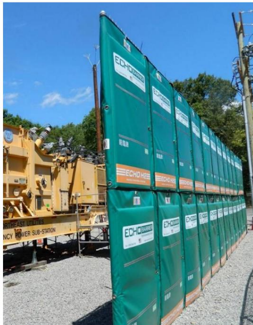
Slika 12, Indikativni oblik privremene barijere od buke
