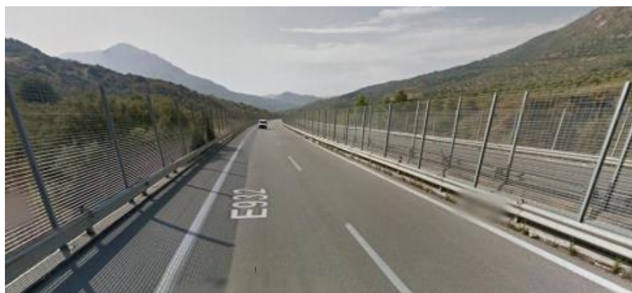
Slika 6. Primer mreže koja sprečava sudar sa letećom faunom [Širina žice: 5 mm, prečnik otvorenog dela: 40 mm, Materijal: čelik (kvadratni ili šestougaoni) + antikoroziivna zaštita (cink/aluminijum)]
